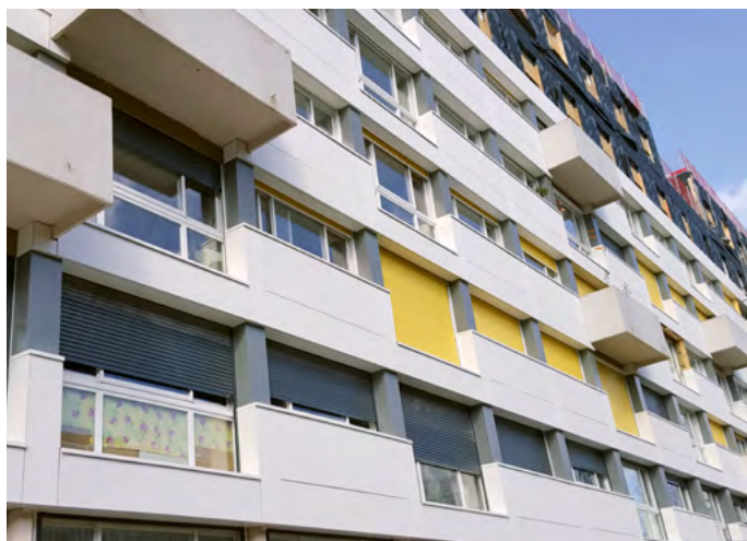
Pendant la réhabilitation
