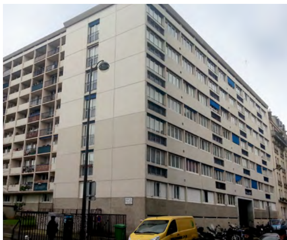
Avant la réhabilitation
