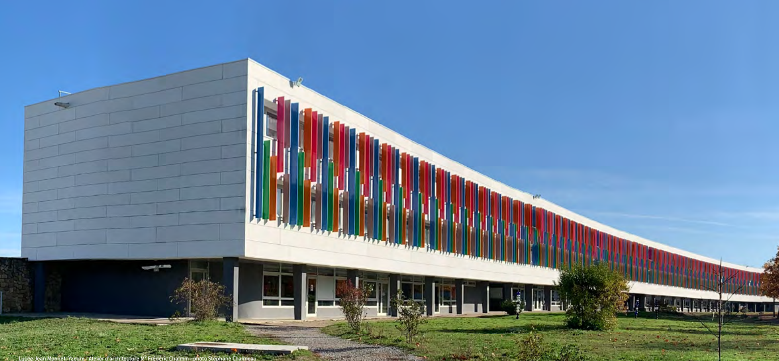
Lycée Jean Monnet - Vézère - Atelier d'architecture M. Frédéric Chalmier - photo Stéphane Chalmier
