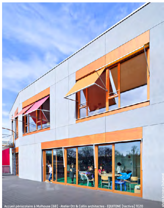
Accueil périscolaire à Mulhouse [68] - Atelier Ott & Collin architectes - EQUITONE [tectiva] TE20
