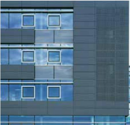
Über verschiedene Bearbeitungstechniken kann eine Vielzahl von Erscheinungsformen der Fassadentafeln erreicht werden. So werden u. a. durch die großflächige Lochung von Fassadentafeln ein Schalldurchtritt in eine dahinter liegende Schallabsorbtionsschicht ermöglicht und zugleich bei hoher ästhetischer Wirkung die technischen Vorteile der Tafel ausgenutzt. Wenn Fassadentafeln in gelochter Form eingesetzt werden, sind für alle EQUITONE
