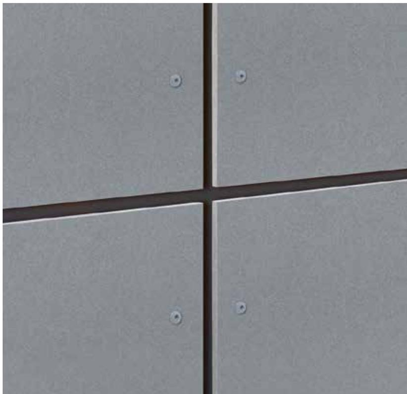
Eine mögliche Konstruktionsvariante zur Verlegung der EQUITONE Fassadentafeln ist eine Unterkonstruktion aus Holz. Die Fassadentafeln werden mit Universal-Schrauben mit Bohrspitze auf der Holzunterkonstruktion befestigt. Die Universal-Schrauben mit Bohrspitze sind farblich an den jeweiligen Farbton der Fassadentafeln angepasst. Sie sind für 8 mm, 10 mm und 12 mm dicke Fassadentafeln erhältlich.
