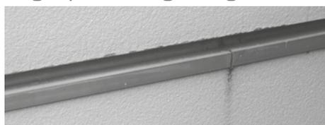
Es wird dringend empfohlen, die horizontalen Fugen zwischen den einzelnen Bekleidungs-tafeln offenzulassen. Bei der Verwendung von Fugenprofilen kann es leicht zur Bildung von Ablaufspuren kommen. Das gilt insbesondere bei Stuhlprofilen. Bei dieser Profilart ist die
