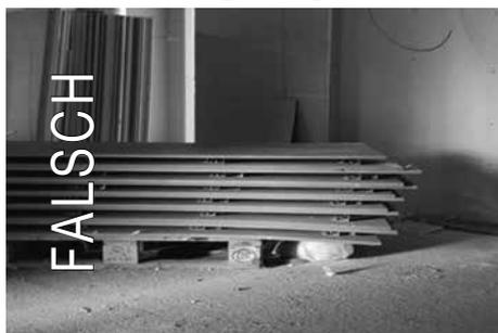
Fassadentafeln aus Faserzement sind auf einer ebenen Unterlage trocken und vollflächig unter einer Baufolie zu lagern. Die bei beschichteten Fassadentafeln zwischengelegte Schaumstoffolie dient zum Schutz der hochwertigen Oberfläche und ist bei Umstapelungen stets wieder einzulegen. Stehende Feuchtigkeit zwischen gelagerten Tafeln kann zu Kalkausblühungen führen, die nicht mehr entfernt werden können und die Qualität der Sichtfläche dauerhaft schädigen.
