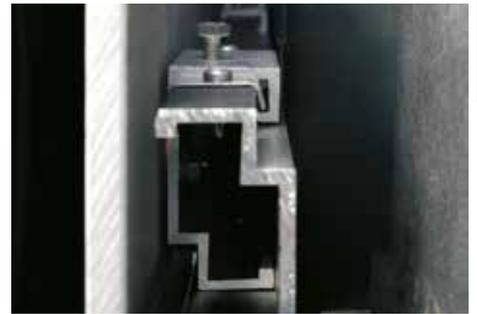
Fertig eingehängte Fassadentafel auf Alu-Uk.
