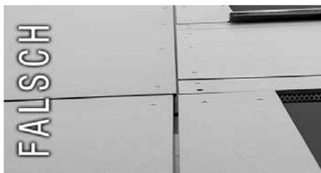
Das Fugenbild hat großen Einfluss auf die Erscheinung einer Fassade. Die Fugenbreite sollte in der Regel zwischen 8 mm – 10 mm liegen. Millimetergenaues Vorbohren der Tafeln, exaktes Aufmaß und die Nutzung von Fugenlehren sind Voraussetzung zur Erzielung eines gelungenen Erscheinungsbildes. Auf ein gleichmäßiges und paralleles Fugenbild ist zu achten.
