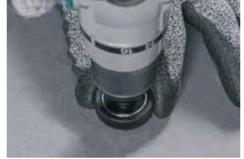
Der Anker wird senkrecht zur Tafeloberfläche in das Bohrloch gestellt. Beim Spreizen mit dem Akku-Schrauber muss das Setzwerkzeug händisch fixiert und leicht mit dem Anker ins Bohrloch nachgeführt werden. Es wird empfohlen, mit einem niedrigen Drehmoment zu beginnen und diesen bei Bedarf zu erhöhen.
