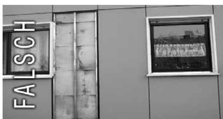
Jede Tafel darf gleichzeitig nur auf Tragprofilen befestigt werden, deren Wandhalter für Festpunkte auf gleicher Höhe liegen. Insbesondere im Fensterbereich muss daher mit getrennten, parallel verlaufenden Einzelprofilen gearbeitet werden, um unzulässige Spannungen zwischen Uk und Bekleidung auszuschließen.
