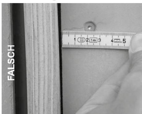
Die Befestigung von Fassadentafeln auf einer Holz-Unterkonstruktion darf keinesfalls mit Senkkopfschrauben erfolgen, denn hierbei bilden sich Festpunkte und das Material kann nicht mehr „arbeiten“. Es entstehen Spannungen, die zu Rissen führen können. Der Bohrlochdurchmesser beträgt 7 mm. Die Befestigung darf gemäß ETA-18/0955 nur mit den Universal-Schrauben mit Bohrspitze 5,5x40 und 5,5 x 50 erfolgen. Bei [pictura] und [natura] PRO sind zusätzlich die EQUITONE Schraubhülsen zu verwenden.
