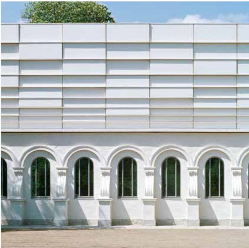
Ein besonderer Reiz in der Fassadengestaltung besteht in den Kombinationsmöglichkeiten von Faserzementtafeln mit anderen Fassadenwerkstoffen wie z. B. Ton, Putz, Glas, Metall, Holz oder Mauerwerk. Der Kontrast zwischen den unterschiedlichen Oberflächen, Strukturen und Farben der eingesetzten Werkstoffe belebt die Fassade und verleiht dem Gebäude seine eigene, unverwechselbare Note.
