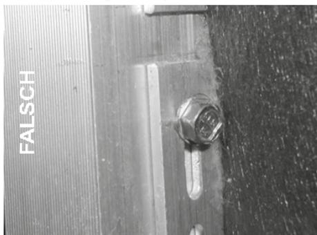
Bei der Verbindung der Bauteile der Aluminium-Unterkonstruktion muss sicher gestellt sein, dass die notwendigen Gleitpunkte auch uneingeschränkt funktionsfähig als solche ausgebildet sind. Montagefehler an der Unterkonstruktion, die zu Spannungen im Gesamtsystem der Fassade führen, haben einen negativen Einfluss auf die Fassadenbekleidung. Das Material kann zu groß werdende Spannungen nicht aufnehmen und es kommt ggf. zu Rissbildungen an der Fassadentafel.
