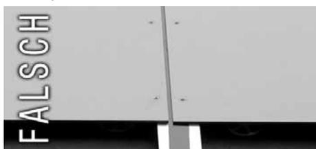
Die Tragprofile im Bereich von Stoßfugen sollten eine Breite von mind. 110 mm haben. Nur so kann unter Berücksichtigung der einzukalkulierenden Montagetoleranzen sichergestellt werden, dass alle Fassadenniete das Profil sicher treffen, ausreichenden Halt haben und keine „Luftnietungen“ auftreten.
