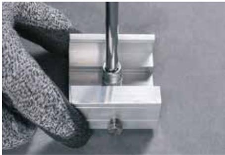
Die Zahnmutter ist mit einem Akku-Schrauber oder geeignetem Steckschlüssel handfest ( $T_{inst} \sim ca. 5 Nm$ ) zu fixieren. Es wird empfohlen, mit einem niedrigen Drehmoment zu beginnen und diesen bei Bedarf zu erhöhen. Die Agraffe soll gegen Mitdrehen gesichert werden.
