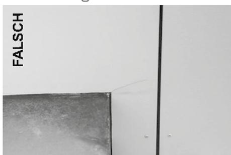
Ausklinkungen bei Faserzementtafeln sollten nicht in einem scharfen Winkel erfolgen. Scharfkantige Ausschnitte bilden sogenannte „Kerbstellen“, die häufig einen Ausgangspunkt für Rissbildungen darstellen. Einmal entstandene Risse „wachsen“ mit der Zeit und die Folge kann Materialbruch sein. Das Risiko des Auftretens der Kerbrisse kann verringert werden, wenn beim Ausklinken an der Ecke eine Bohrung gesetzt und so eine leichte Abrundung geschaffen wird.
