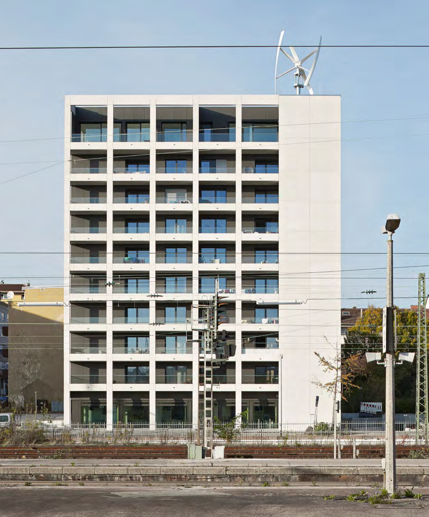
Nadbudowa i generalna renowacja domu mieszkalnego do standardu budynku zero-energetycznego Architekt: Freivogel Architekten Produkt: Płyty elewacyjne EQUITONE [textura] Zdjęcie: Dietmar Strauß
