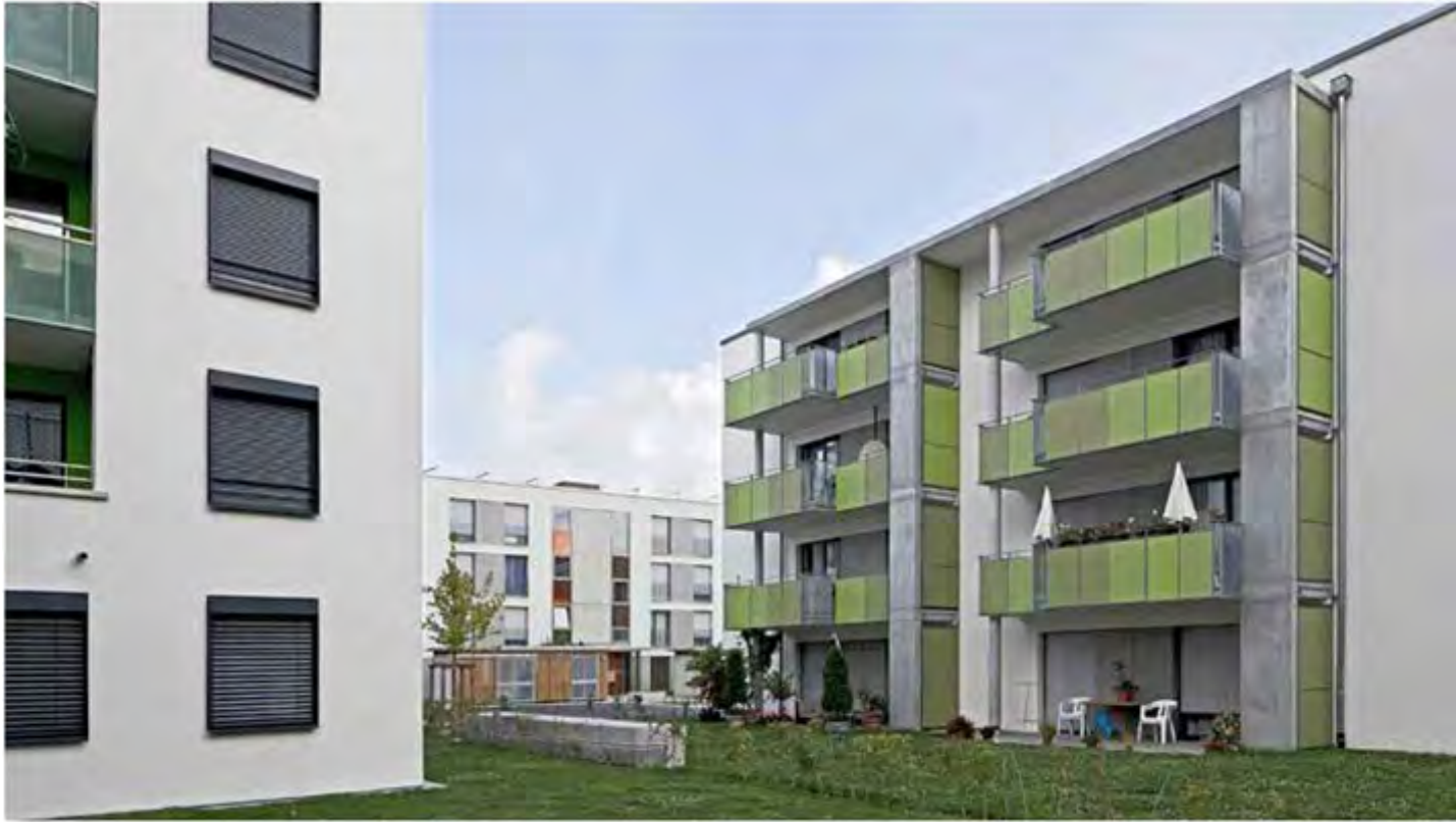
Osiedle mieszkaniowe Raimannweg, Freiburg Architekt: mgr inż. Andreas Barton, Freiburg Produkt: Płyta balkonowa EQUITONE [textura] Zdjęcie: Markus Löffelhardt, Berlin
