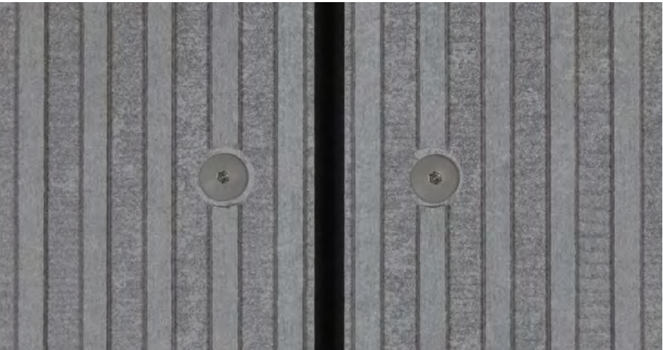
Punkt mocowania na drewnianej konstrukcji nośnej; mocowanie w osi wybrzuszenia płyty.
