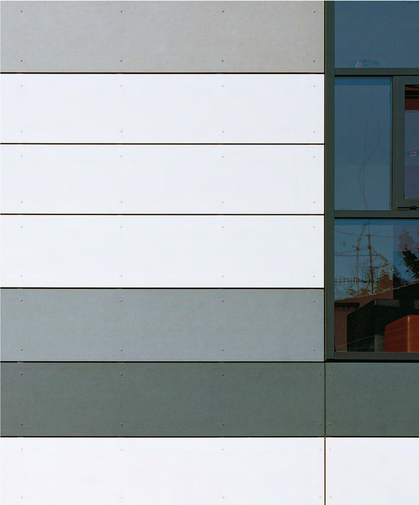
Theodor-Heuss-Gymnasium, Göttingen Architekci: Ahrens Grabenhorst Architekten BDA, Hanover Produkt: Płyty elewacyjne EQUITONE [natura] Zdjęcie: Klaus Dieter Weiss, Minden
