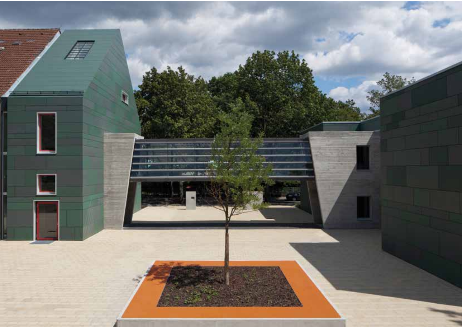
"Schule an der Jungfernhöhe" in Siemensstadt (Spandau), Berlin Arch: Doerr Ludolf Wimmer (dlw Architekten)
