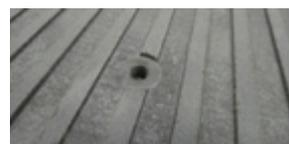
Do ponto de vista estético, ao perfurar o EQUITONE [lína], recomenda-se alinhar os parafusos com as nervuras do painel. Ao atuar dessa forma, a cabeça do UNI screw fica menos visível. Isso resultará na necessidade de um perfil de madeira mais largo, de até 140 mm, que será usado atrás das juntas verticais.
