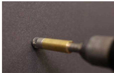
Insira o rebite com a bucha (reductor de furos) no orifício pré-perfurado e coloque o rebite. Certifique-se de que o rebite esteja perpendicular à face do painel. A utilização da ferramenta de colocação de rebites pode ajudar, caso contrário, a cabeça do rebite pode marcar a superfície do painel. O rebite deve ficar plano sobre o painel da fachada.
