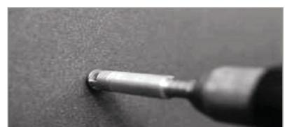
Установите заклепку с красной втулкой в полученные отверстия. Убедитесь, что заклепка плотно прилегает к лицевой стороне панели (используйте насадку для монтажа заклепок), и при помощи вытяжного пистолета зафиксируйте заклепку. Несоблюдение этих требований может привести к неровной установке заклепки, попаданию влаги в отверстие в панели и повреждению лицевой стороны панели.
