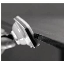
Нанесите гидрофобизатор на торец панели, начав с угла. Аппликатор необходимо наклонить к внутреннему торцу панели. При необходимости обмакните аппликатор повторно.
