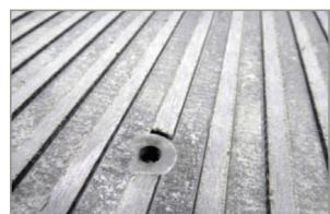
Для сверления отверстий в фиброцементных панелях EQUITONE [linea] LT используйте специально разработанное сверло-фрезу.
