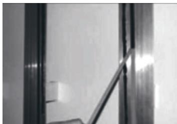
После высыхания грунтовки можно наносить клей. После нанесения клея удалите защитную бумагу с уплотнительной ленты и установите панель на подсистему (рекомендуемое время – 10 минут).
