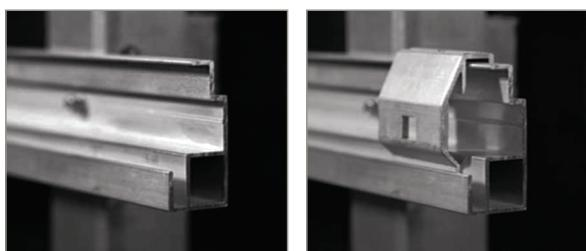
Аграфы, закрепленные на задней стороне панели, крепятся к горизонтальным направляющим, закрепленным на подсистеме. Горизонтальная направляющая крепится к вертикальным L-образным направляющим подсистемы. Обязательно соблюдайте принцип фиксированных и свободных точек крепления. Горизонтальные направляющие обычно имеют 3 м в длину. Оставьте зазор 20 мм через каждые 3 метра между горизонтальными направляющими.
