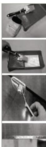
Торцы всех панелей с покрытием необходимо обрабатывать гидрофобизатором Luko («Люко»). Таким образом производится защита панелей (EQUITONE [natura], EQUITONE [natura] PRO) от высолов в местах проникновения влаги между лаком и фиброцементной плитой через необработанный торец, а также предотвращается выцветание торцов панелей (EQUITONE [textura], EQUITONE [pictura]).
