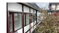
Nij Smellinghe, Drachten, Nederland Ziekenhuisrenovatie met hergebruikte gevelpanelen uit 1996
