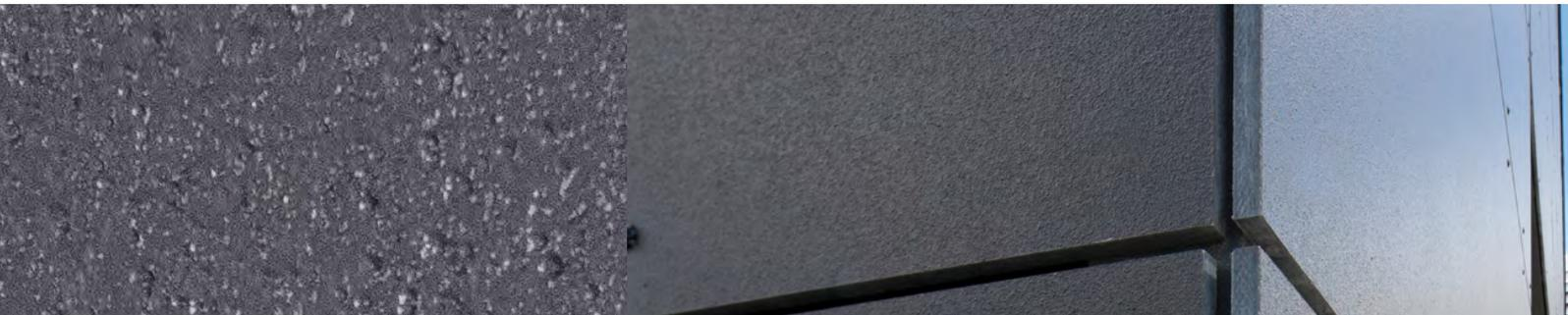
Panneau de bardage en fibres-ciment recouvert d'une couche acrylique à structure granuleuse. Surface légèrement grainée et brillante.
