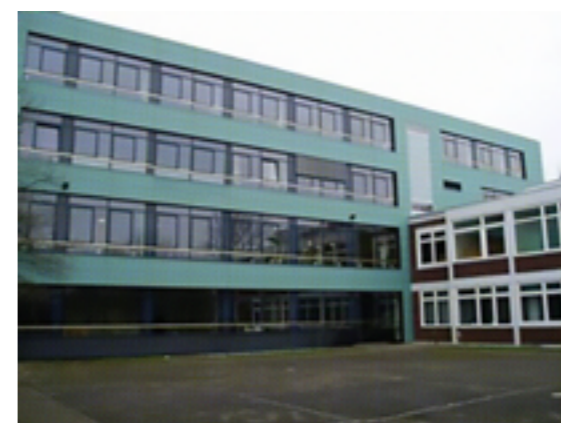
Pladerne blev afmonteret fra et tidligere ungdomscenter...
